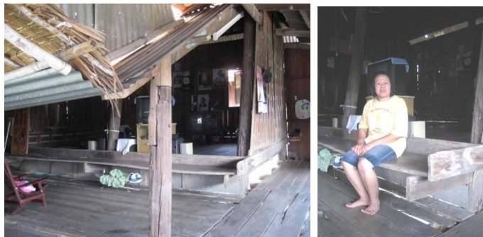
รูป 11 ไม้แป้นทอง และการถ้ำระดับของเรือนนอนและระเบียง
